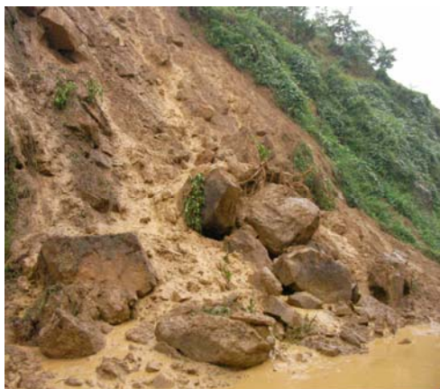
大雨後山體滑坡，險象環生
